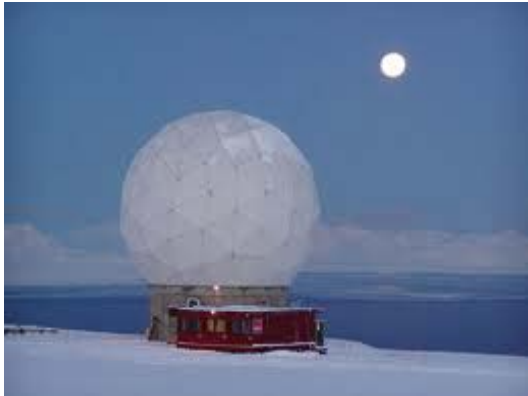
Eksempel på antenne med radom (SvalSat)
