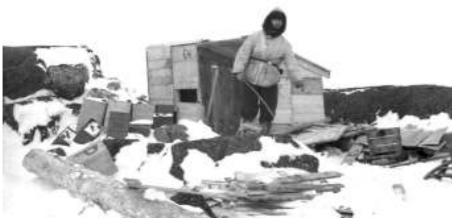
Film 22, 04. april 1945: Nødradiohytten under konstruksjonen. Kilde: E. Dege, med vennlig tillatelse.
