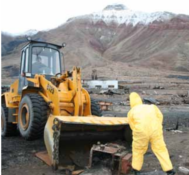
Lekkende elektrisk utstyr er fjernet. Her fra oppryddingsarbeide utført i Pyramiden. Foto: Halvard R. Pedersen
