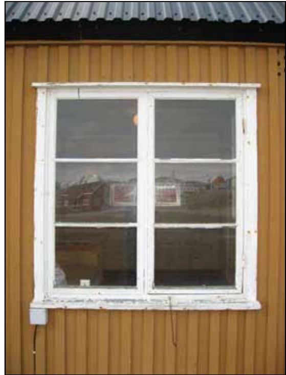
London 1. To-fags vindu med midtpost, tre ruter i hver ramme. Malingslitt, men godt vindu. Foto: Siri Hoem, Sysselemannen 2007.
