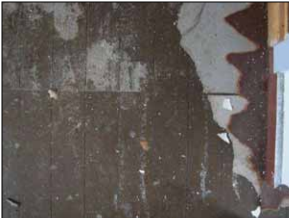
Gamle telegrafren. Malt tregulv som bør renses og males som opprinnelig. Rester av linoleum dokumenteres.
