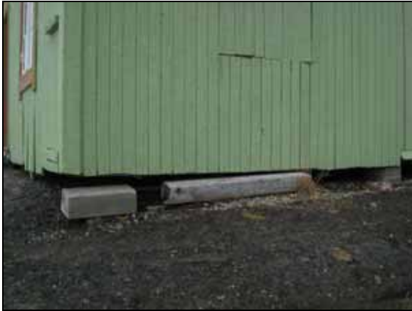
Hytte lysegrønn. Utglidd fundament av boks.
