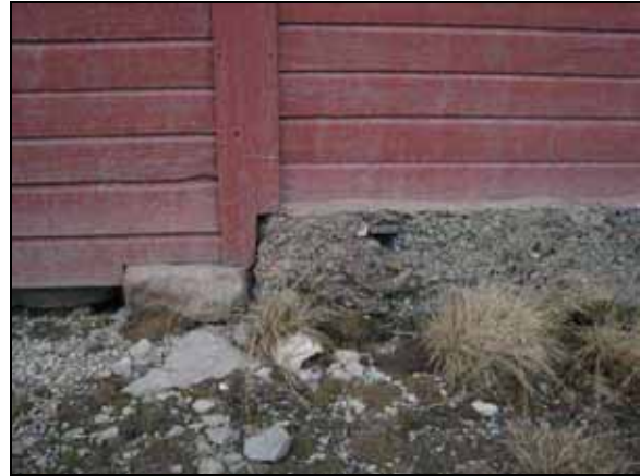
Butikken. Fundament dels på støpte puter, dels på støpt ringmur. Begge foto: Siri Hoem, Sysselmannen 2008.
