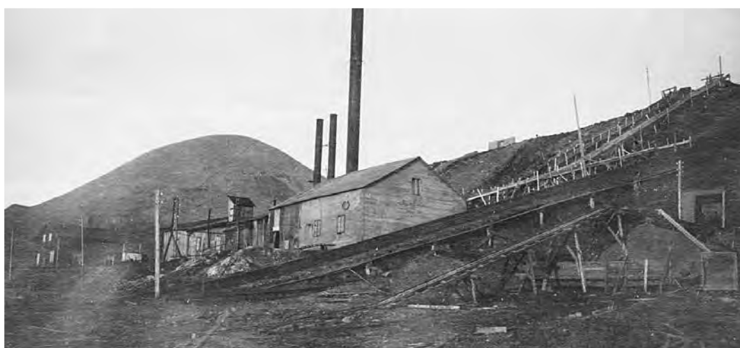
ACCs kraftverk fra 1910 13 med tilbygg fotografert i 1920. Kullrenne ned fra brinken og lenger til venstre porten til kjølevanndammen. T.v. bolig for kraftverkets ansatte.
