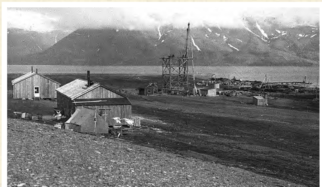
Lagerplassen for kull og lastekaia 69 på Hotellneset under bygging i 1920.
