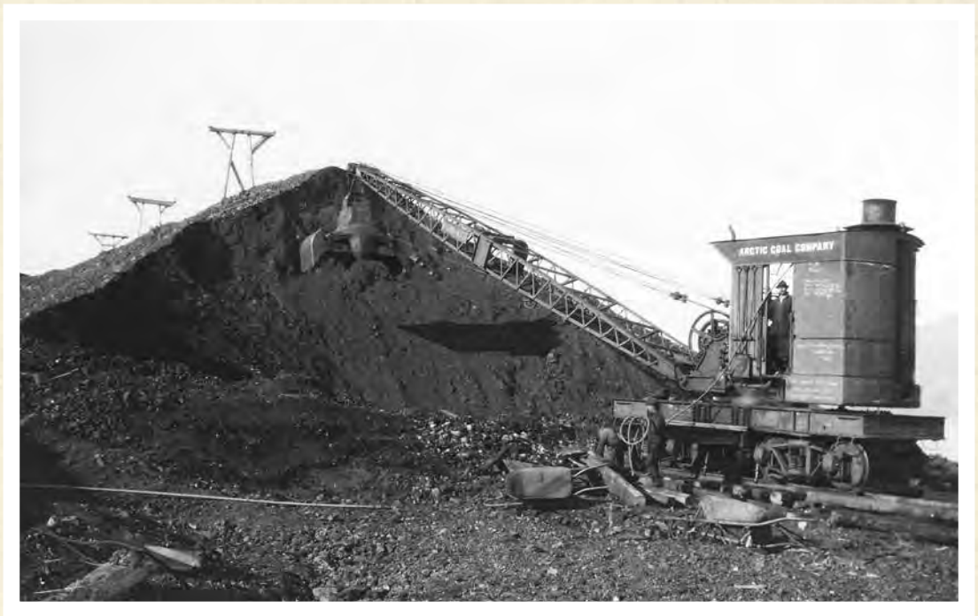
Brownhoist-kran på kullagret 15 nedenfor Taubanesentralen i 1916. Understellet står fremdeles.
