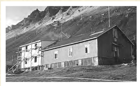
Det første sykehuset 19 under påbygging i 1939-40. Den eldste delen var fra 1916 og var et av de første hus SNSK satte opp etter overtagelsen av ACC.
