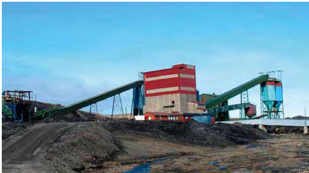
Skeide- og sorteringsverket, ORV i 2009 71 . Bygget i 1954 og ombygget flere ganger. Skiller ut stein og sorterer kull etter størrelse. Også kalt Oppredningsverket og kalt renseverket. Her lå også SNSKs laboratorium for undersøkelse av kullkvaliteter. Revet i 2010.
