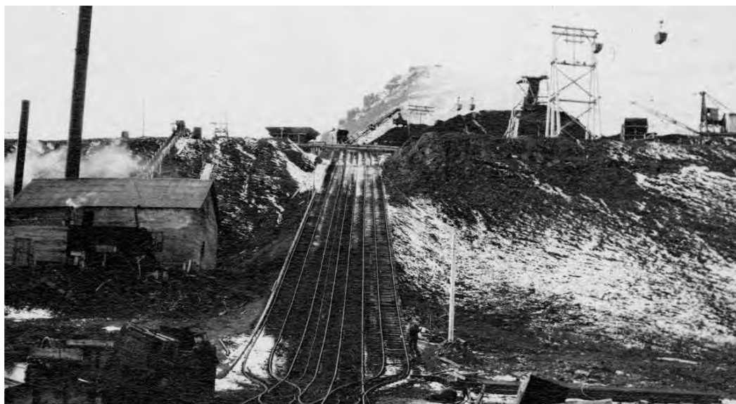
Skjæringa med skinnegangen fra kullageret 15 ned til lastekaia i 1916.
