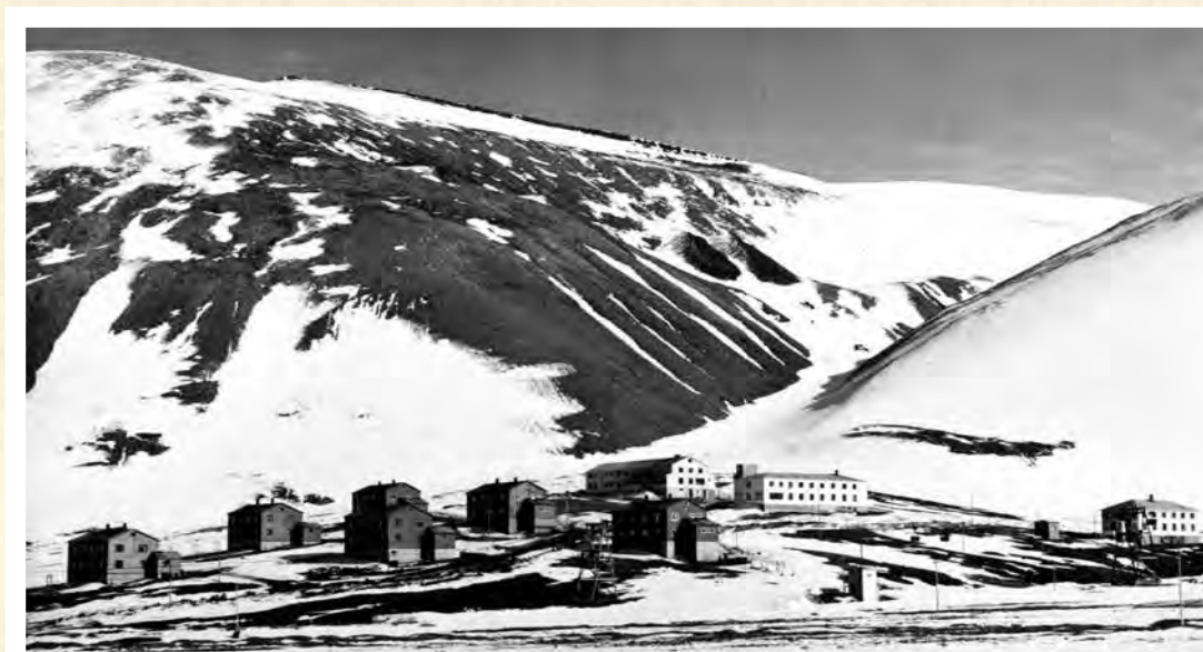
Haugen i 1948. Fra venstre seks familieboliger 86 , Funksjonærmessen 87 øverst med det andre sykehuset 88 t.h. Det andre kontoret helt t.h. 90 I snøen oppe t.h. branntomta etter det første kontoret.
