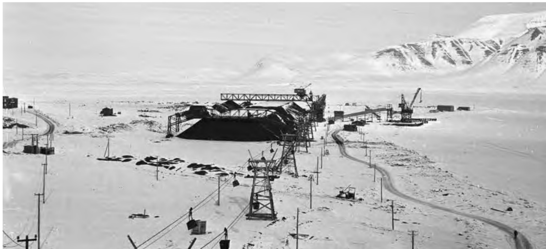
Kullageret og lasteanlegget 69 på Hotellneset på 1950-60 tallet. Lengst borte Titankranen 70 fra 1953. Den står i dag.
