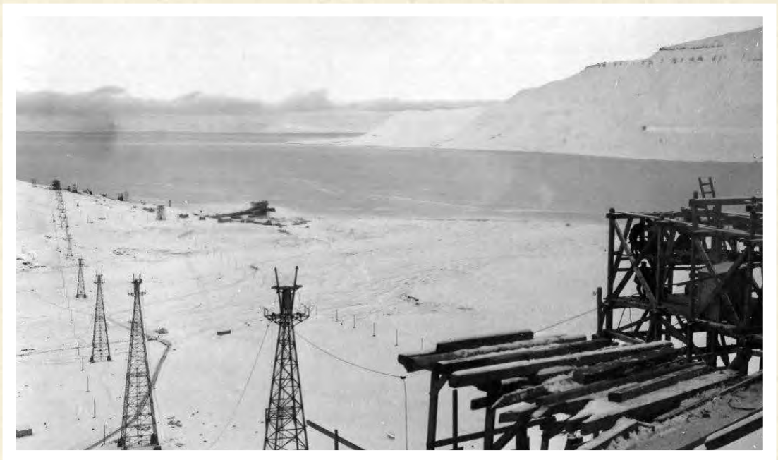
Taubanen fra Gruve 2a 4 i 1921. De seks nærmeste bukkene er av stål og ble kalt tårn.
