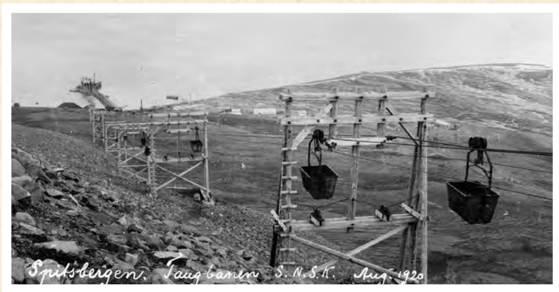
Longyearbyens første taubane ble bygget i 1906. Den gikk fra Gruve 1a, Amerikanergruva, og til kullagret og videre til lastekaia som ligger til venstre i bilde. Denne taubanen var i drift til 1920. Foto SNSK.
