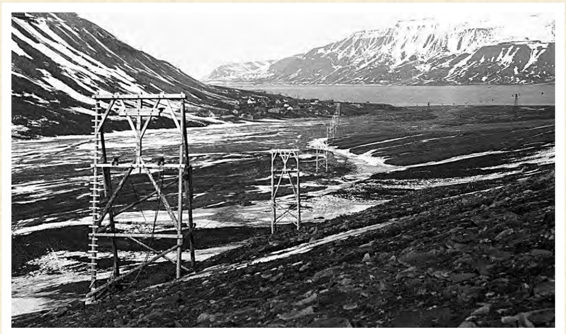
Taubanen fra Gruve 2b 5 under oppføring i 1937.
