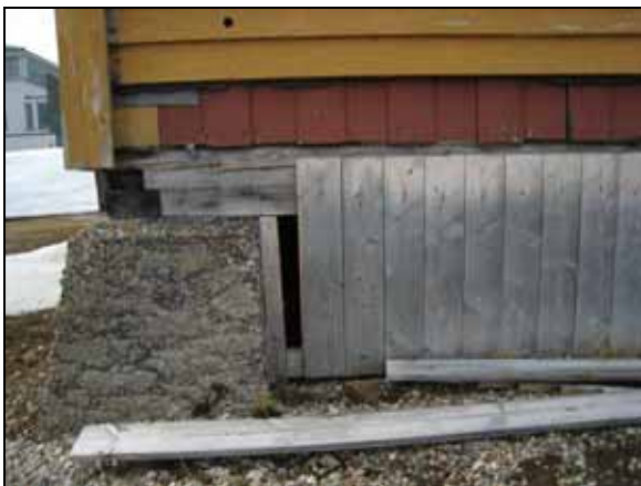
Amundsenvillaen. Mulighet for tilbakeføring/avdekking av opprinnelig panel. Dette kan gjøres på dokumentert grunnlag. Vinduene plassering og utførelse er endret og kan tilbakeføres på sikkert grunnlag mht. plassering (tegninger, fotografier, spor i veggen). Detaljutformingen må eventuelt skje på analogt grunnlag, dvs. basert på opprinnelige vinduer med tilsvarende utforming annet sted i Ny-Ålesund. Foto: Siri Hoem, Syssemmannen 2008.
