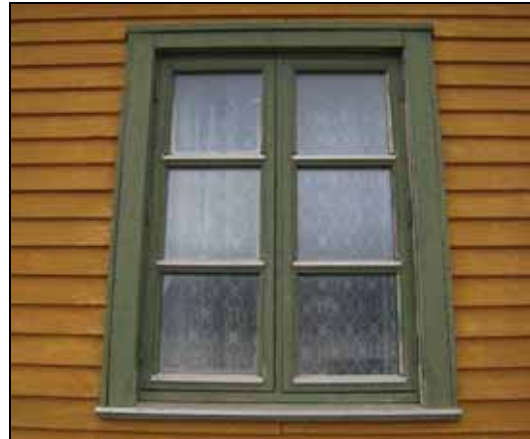
Amundsenvillaen. Mulighet for tilbakeføring/avdekking av opprinnelig panel. Dette kan gjøres på dokumentert grunnlag. Vinduene plassering og utførelse er endret og kan tilbakeføres på sikkert grunnlag mht. plassering (tegninger, fotografier, spor i veggen). Detaljutformingen må eventuelt skje på analogt grunnlag, dvs. basert på opprinnelige vinduer med tilsvarende utforming annet sted i Ny-Ålesund. Foto: Siri Hoem, Syssemmannen 2008.
