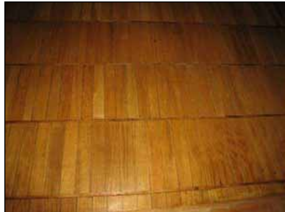
Hvitt hus: Stavparkett som skal bevares. Begge foto: Siri Hoem, Sysselmannen 2008.
