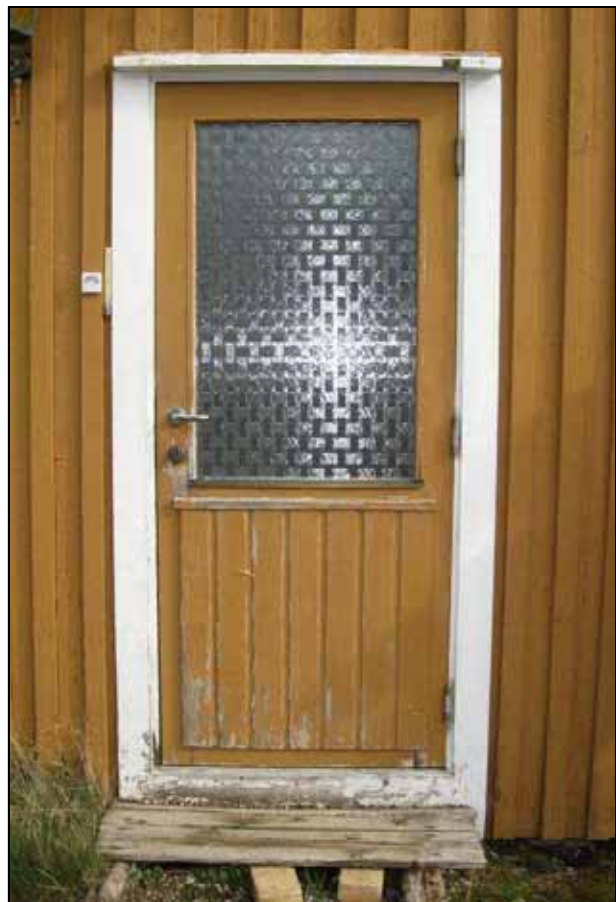
London 1. Ramverksdør med glass og panelt underfelt, vannbrett over. Foto: Siri Hoem, Sysselmannen 2007.
