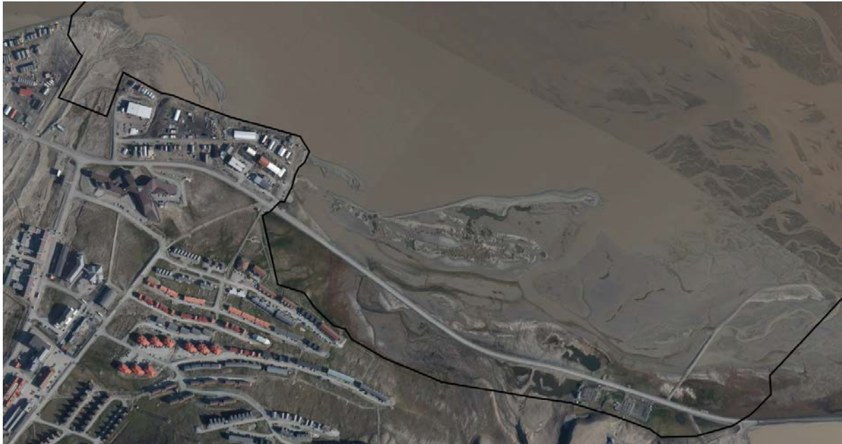
Figur 2.5 Noe av infrastrukturen i Longyearbyen er etablert i Adventdalsdeltaet. Strandengene på sørsiden av deltaet er i dag avskåret fra deltaet av Adventdalsveien. Utløpet av Longyearrelva regnes i denne rapporten som en del av Adventdalsdeltaet.
