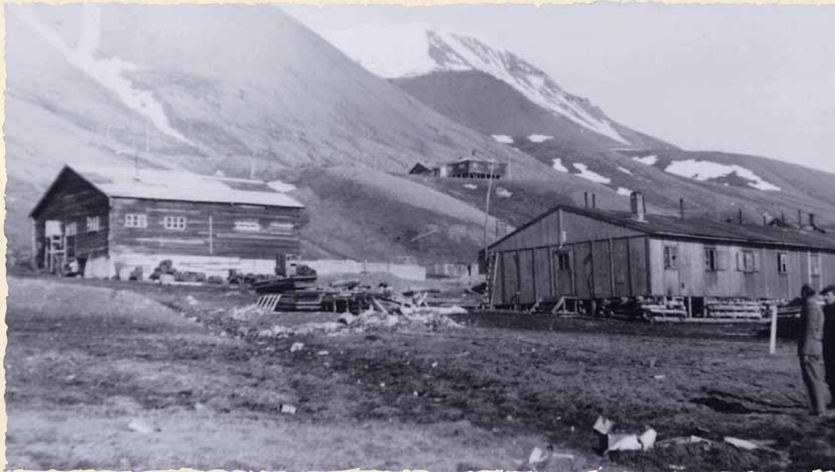
Ved driftsnedleggelsen ble anlegget forlatt slik det var. Redskaper, biler og annet utstyr ble liggende som et minne over menneskene som arbeidet i Hiorthhamn. Det er like viktig å ta vare på løse gjenstander som de mer påfallende bygningene.
