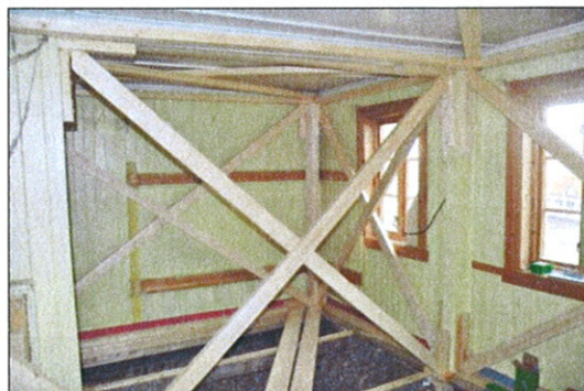
Avstiving av Villa Fredheim før flytting. Foto: Sigbjørn Haugen/Sysselmannen på Svalbard
