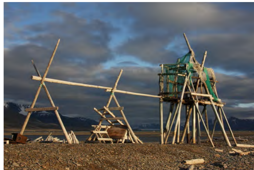
Bildet ovenfor: kjøttstativet; t.h.. røykeovn med brennkammeret, som er satt et stykke nedenfor røykekammeret.
