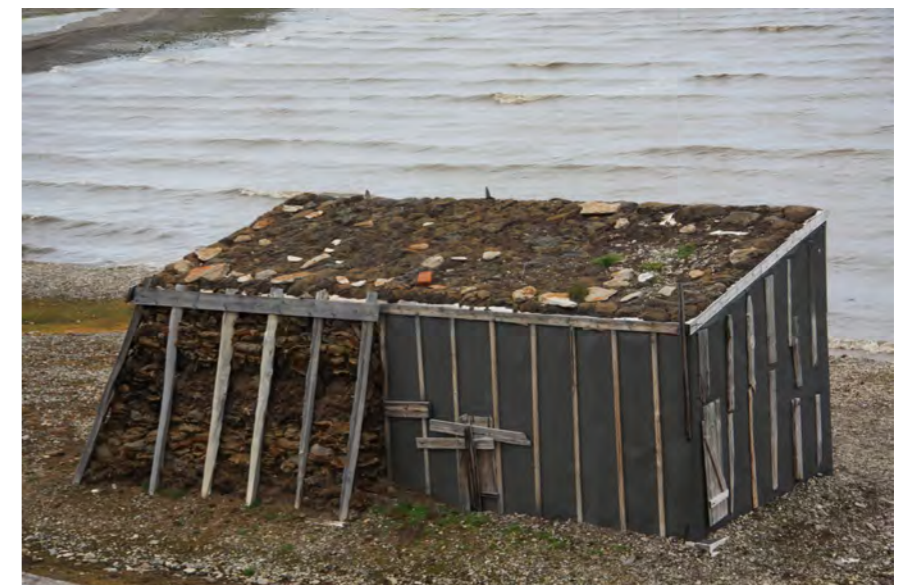
Bilde 8652 og 8660: A-fasaden og C-fasaden sett fra brinken.
